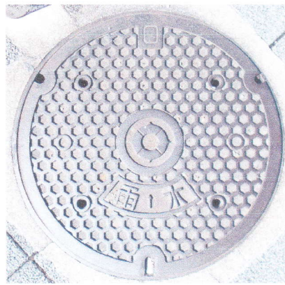
豊中市の標準的なマンホール蓋。亀甲模様(蜂の巣模様)。「汚水」「雨水」「合流」の3種がある。文字の中央の矢印は水が流れる方向を指している。外枠は2重、3重などがある。
