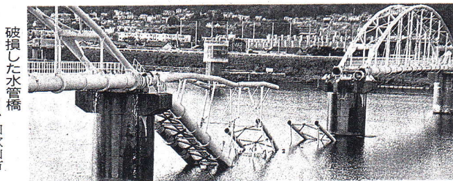
破損した水管橋 11月3日、和歌山市
