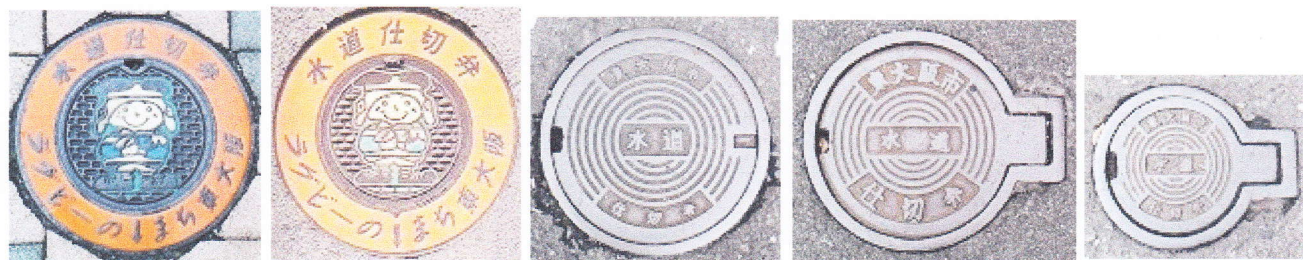
東大阪・水道仕切弁 5種
