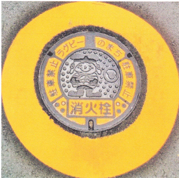
ラグビーのまち・消火栓
