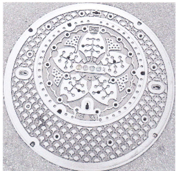
親子マンホール(東京・下水道 管敷設 合流・T-20)
