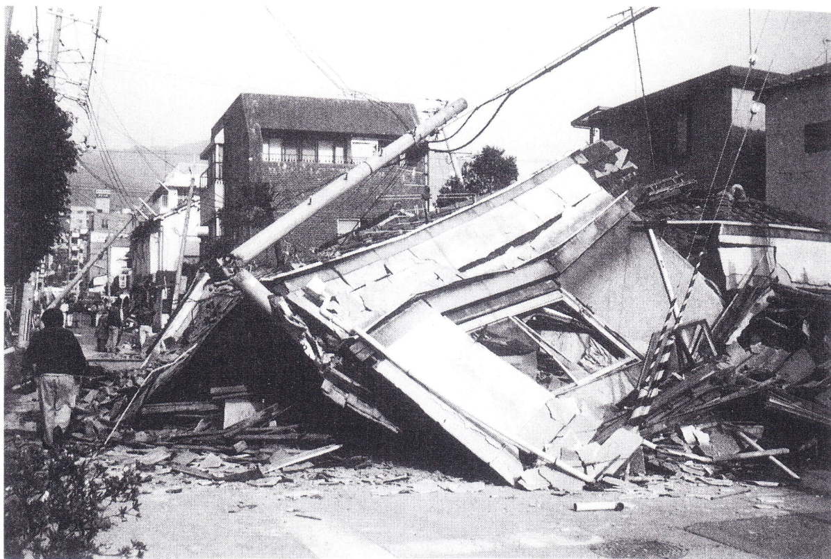
▲1971年の耐震基準の改善などが反映しなかった古い木造住宅が軒並み倒壊した。
