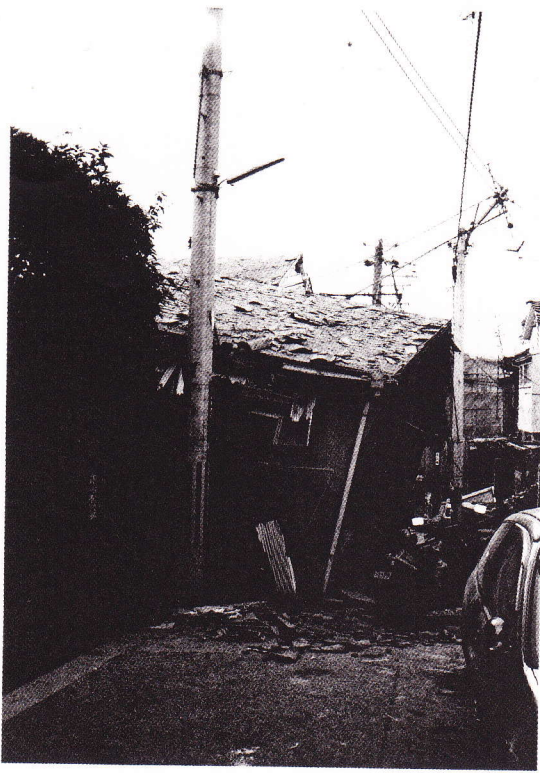
1階部分を失って、つんのめるように倒れ込んで、道路をふさいだ家屋。すべて落ちた屋根瓦が、衝撃の激しさを物語っている。
