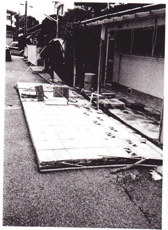
形のままだにバツタリと倒れたブロック塀。6時前というのは新聞配達の時間で、何人かが倒れたブロック塀の下敷きになって死んだ。
